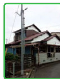
⑯街路灯設置
